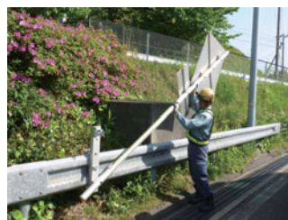
規制標識を筒部に挿入し回転させながら立てる
