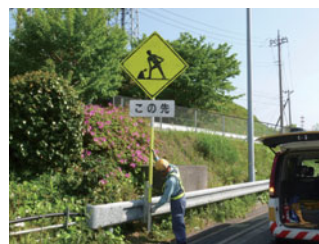
サドル部を閉め、蝶ネジで固定。筒部をストッパーでロックする
