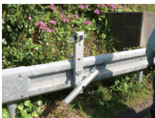
取付金物をガードレールに設置
