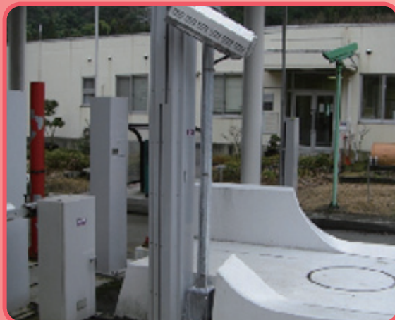
車両検知器周辺の広範囲を凍結防止、積雪防止としての設置例
