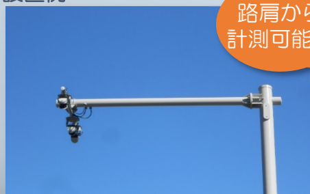
路肩張出柱(単独柱)
